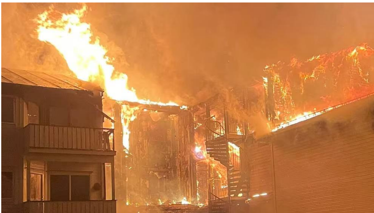
Bilde 2: Brann i leilighetsbygg – Bruveien, Bodø – 16. august
